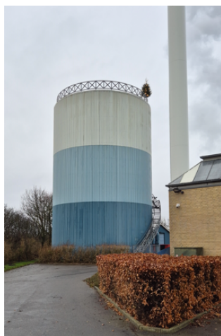
Akkumuleringsstank – "Varmebank"
